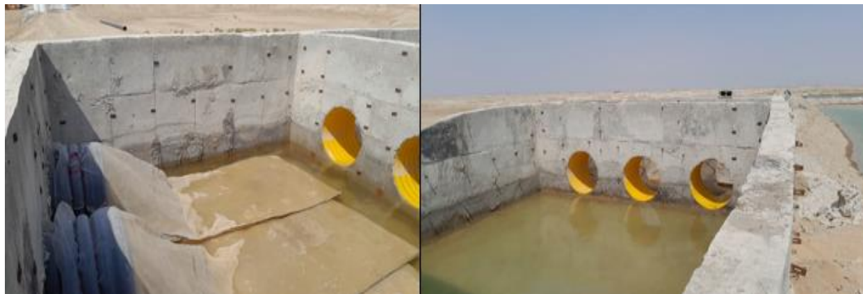
شکل ۲. نمایی از ورودی فیلتراسیون ۳ مرحله ای که شامل توری های ۱۰۰، ۳۰۰، ۵۰۰ میکرون می باشد ( عکس از: نگارنده)
